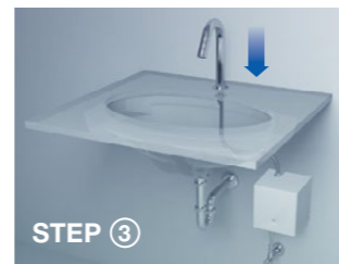
ติดตั้ง TOUCHLESS FAUCET สายน้ำดีเข้ากับกล่องควบคุม Attach the TOUCHLESS FAUCET and connect the water supply line with the control box.
