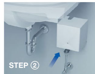
ติดตั้งแผงบังคับ และติดตั้งกล่องควบคุม Install the control box.
